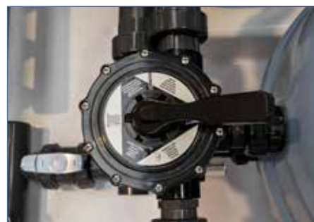
Valvola selettoria dotata di bocchettoni per semplificare le operazioni di manutenzione.
